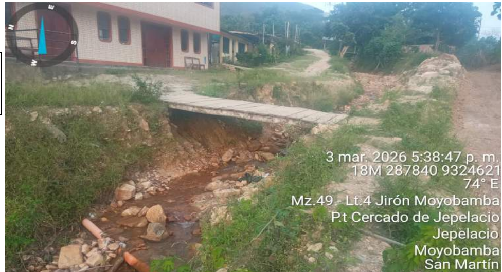
IMAGEN N°02: CAUCE DE LA QUEBRADA DISYACU, SE OBSERVA VIVIENDAS Y PUENTE PEATONAL EXPUESTO A EROSION DE
