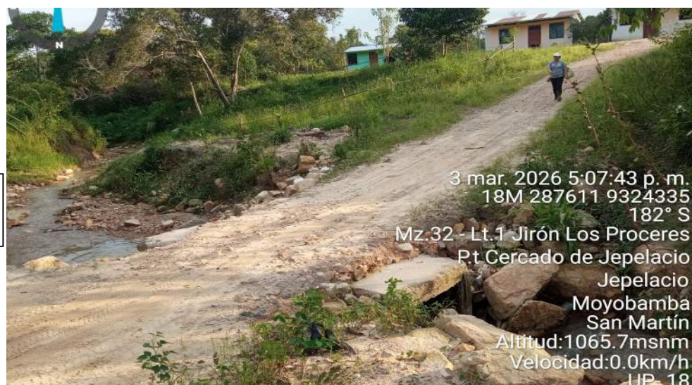
IMAGEN N°03: CAUCE DE LA QUEBRADA DISYACU CON EROSION DE LA RIBERA EN AMBAS MARGENES
